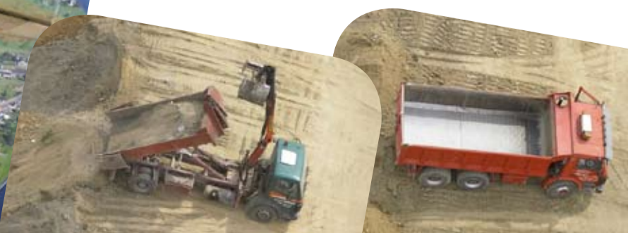
<< Les premiers travaux préparatoires sur la zone ont débuté en novembre 2008
